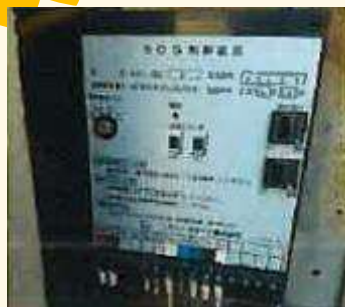
◆ 地絡継電器の取替
