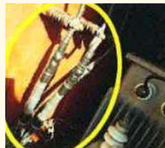
◆ 高圧ケーブルの取替
