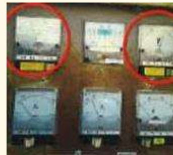
◆ 電圧計の取替
