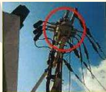
◆ 気中開閉器の取替
